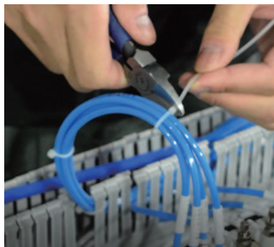
图 4-30 使用绑扎带绑扎气管
