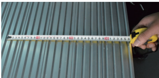
图 3-9 底板的安装位置测量标记
