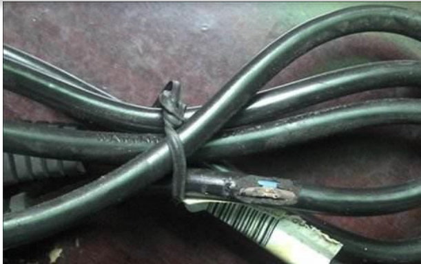
检查电缆是否破损
