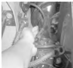
图 5-69 检查减振器中渗漏情况
