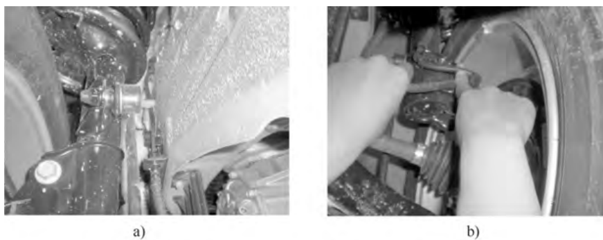
图 5-111 检查制动管路老化、损伤情况
