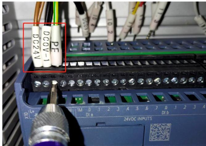
完成24V、0V、接地线的接线
