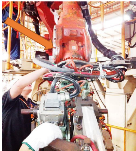
关节/注油处漏油
